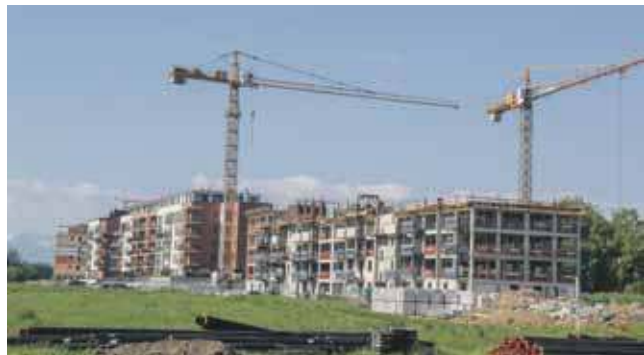
130 mieszkań z rządowego programu już powstaje. Ilu będzie chętnych na takie lokum?
