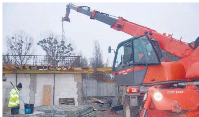
Pogoda tej jesieni sprzyjała prowadzeniu prac budowlanych. Fot. Łukasz Sułowski/Zoo Zamość
