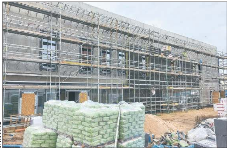
W budynku przyszłej pływalni została już wstawiona część okien
