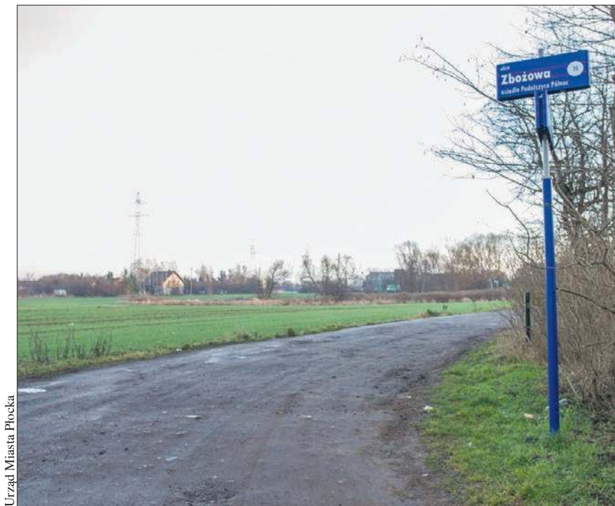
Rozpoczęła się budowa brakującego fragmentu ulicy Zbożowej.
