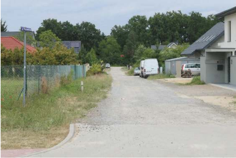
Dokumentacja budowy ulic Poziomkowej (na zdjęciu) i Jagodowej powinna być gotowa do końca tego roku
