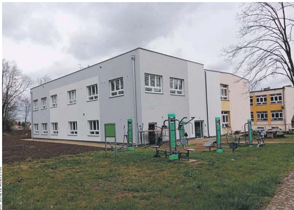
Nowy budynek przy Szkole Podstawowej w Zalasiu stanął tuż przy starym
