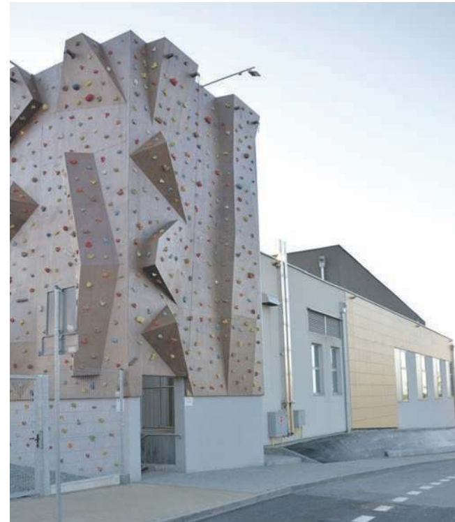
Ścianka wspinaczkowa przy krytej pływalni w Libiążu
