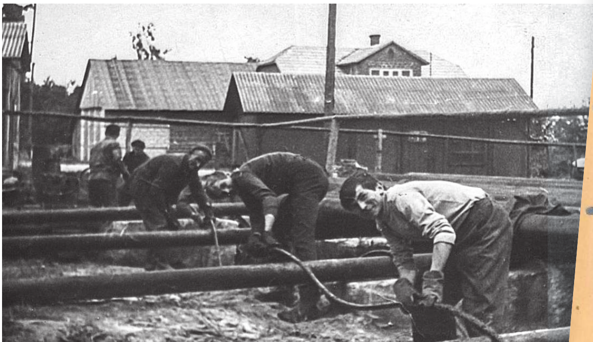
Budowa pierwszych gazociągów – Kopalnia Przemyśl-Zachód
