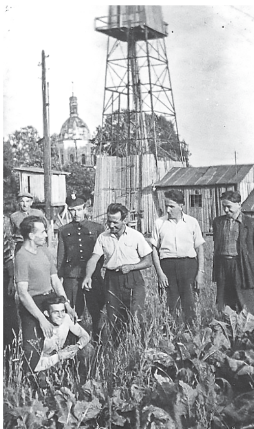
W tle – wiertnia na otworze Jaksmanice-5 w Buszkowicach
