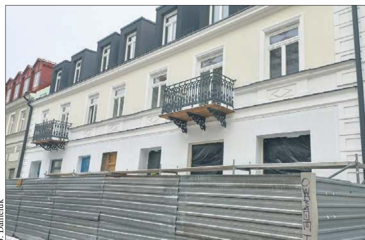
Przebudowywana kamienica przy ul. Grodzkiej 8
