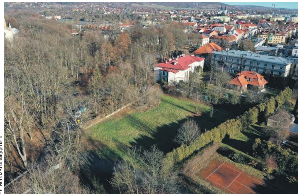
Na tym pustym placu widocznym z góry ma powstać sala gimnastyczna
