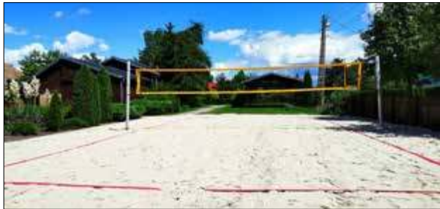
Do przygotowania boiska o wymiarach 12x20 metrów wykorzystano 150 ton piasku. Powstało na niewykorzystanej dotąd, pokrytej trawnikiem przestrzeni przy ośrodku kultury
