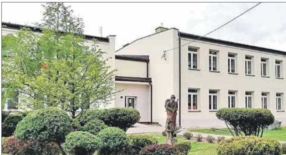
Ruszył remont pomieszczeń w Szkole Podstawowej im. Samodzielnej Grupy Operacyjnej „Polesie” w Jabłoniu. W budynku ma powstać dwuoddziałowy żłobek z miejscami dla 25 dzieci. Prace mają zakończyć się już we wrześniu. Koszt inwestycji oszacowano na 334 501,24 zł
