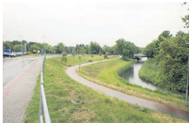
Bulwary przy ul. Ciepłej.
