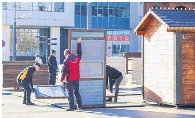
FOT. UM KATOWICE
