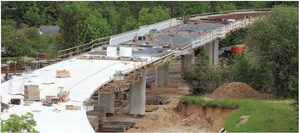
Na estakadzie tory zostaną ułożone do końca wakacji
