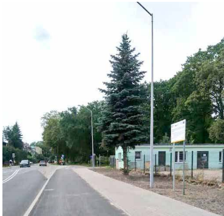
Nawierzchnię ścieżki wykonano z masy bitumicznej. Dodatkowo na ulicy Spokojnej dla pieszych powstał chodnik z kostki betonowej
