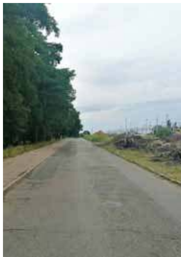
Od dzisiaj ulica Barnima zostanie wyłączona z ruchu pojazdów, możliwy będzie tylko ruch pieszych
