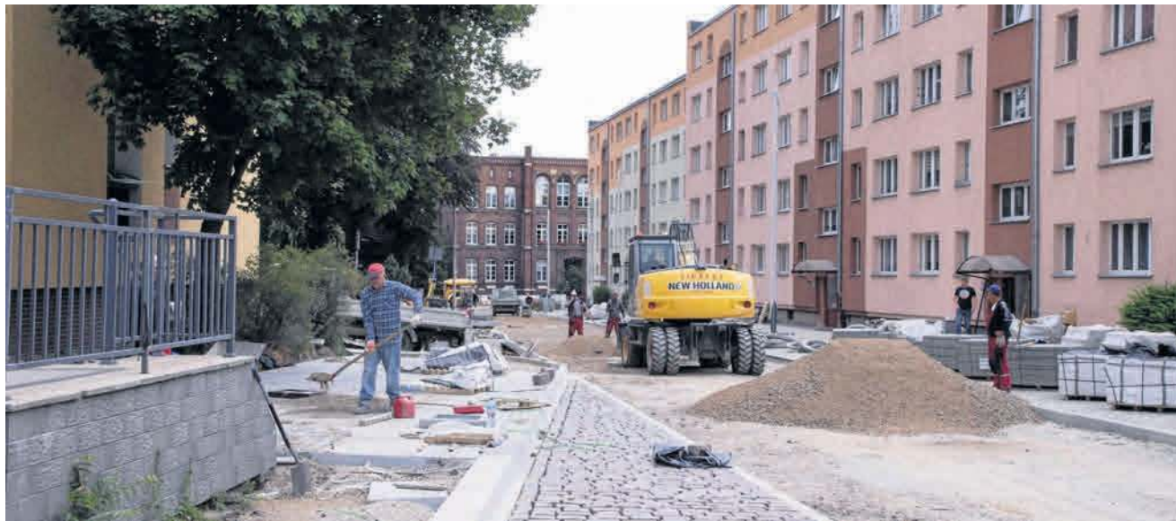
W pierwszych trzech miesiącach roboty były wykonywane przede wszystkim na odcinku od ulicy Kazimierza Wielkiego do Grodzkiej
