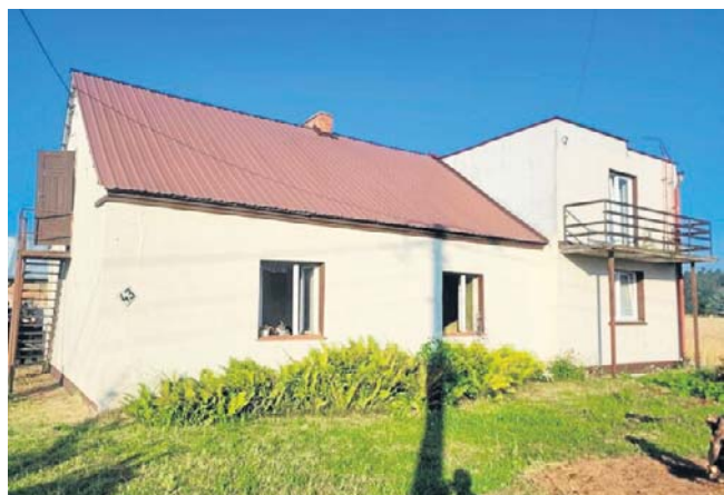
Wybuch gazu w budynku jednorodzinny w gminie Brzeziny. Jedna osoba została poszkodowana.
