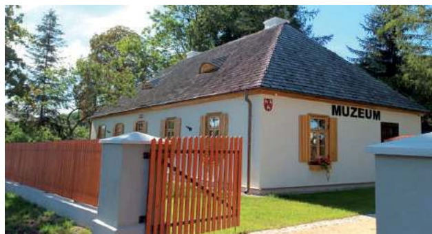
Prace remontowe w budynku muzeum w Woli Okrzejskiej trwały od lutego 2021 r. (fot. Janusz Kryczka/ Starostwo Powiatowe w Łukowie/Muzeum im. H Sienkiewicza w Woli Okrzejskiej)
