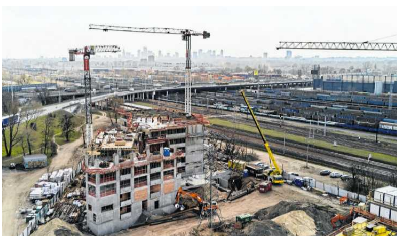
• Budowa osiedla przy estakadzie Trasy Toruńskiej
