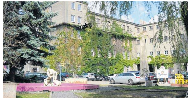
Chodzi o teren o powierzchni ok. 72 hektarów, z czego 6,6 ha to obszar po dawnych Lubelskich zakładach Tytoniowych
