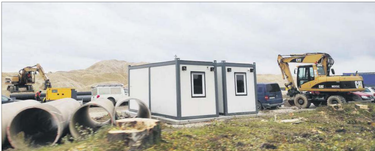
Trwają prace przy budowie autostrady A2 w powiecie bialskim na odcinku Swory – węzeł Biała Podlaska (Cicibór)
