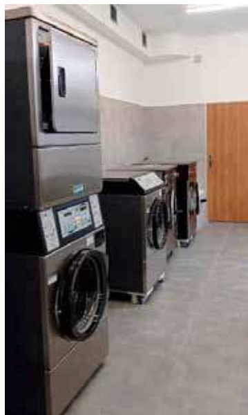
Tak wygląda pralnia po gruntownym remoncie
