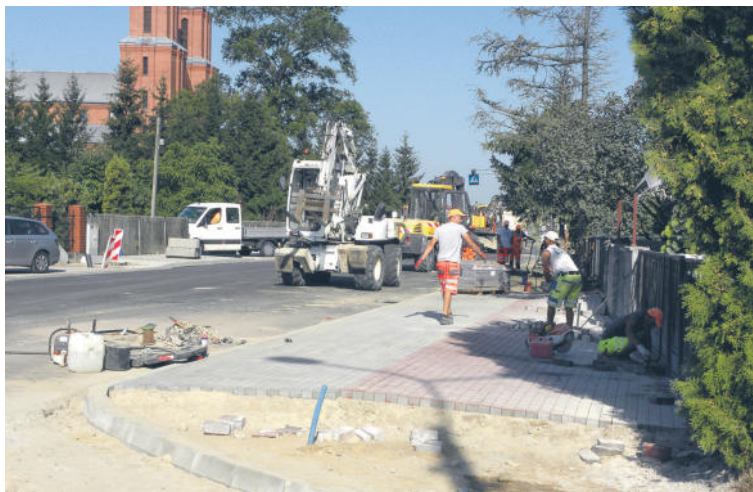
Prace na ul. Popiełuszki
