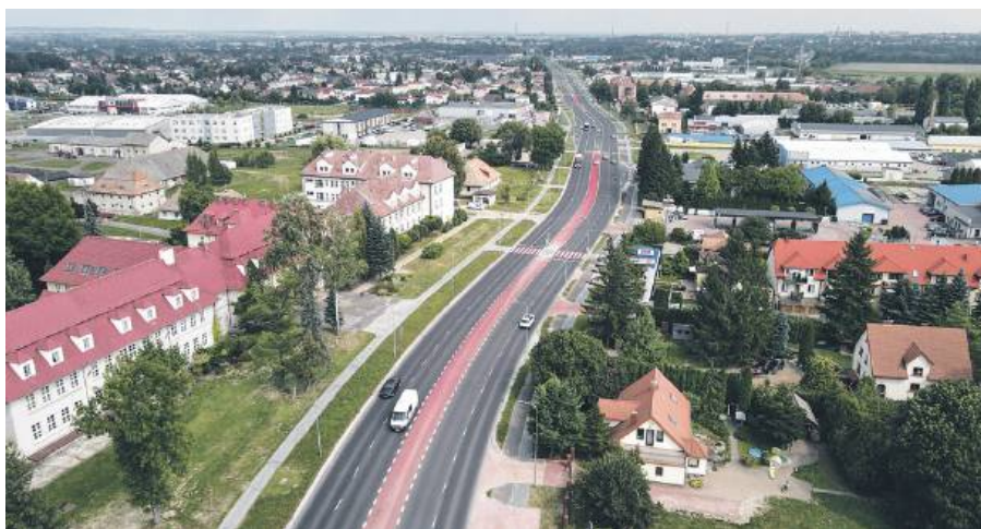
Ul. Szczepczeska (widok w kierunku ul. Dzieci Zamojszczyzny)
