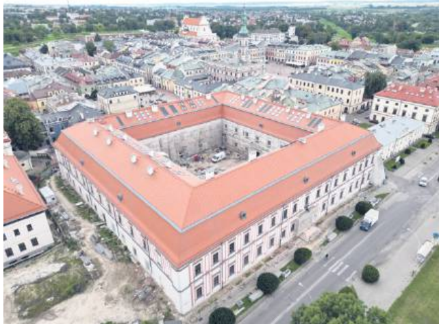
Trwają prace, które przywrócą budynkowi Akademii Zamojskiej formę z drugiej połowy XVIII w.
