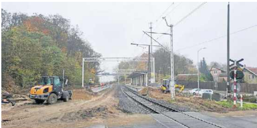
Szczecin Gołębino. Trwają prace przy układaniu drugiego toru linii kolejowej nr 406
