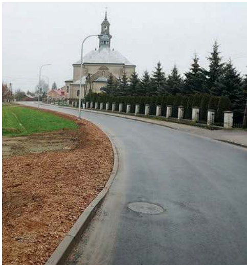
Radzanów. Przebudowana droga została dostosowana do koncepcji kompleksowej modernizacji rynku w tej miejscowości
