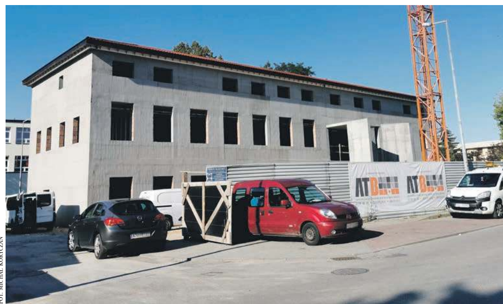
Trwa budowa nowej biblioteki w Krzeszowicach
