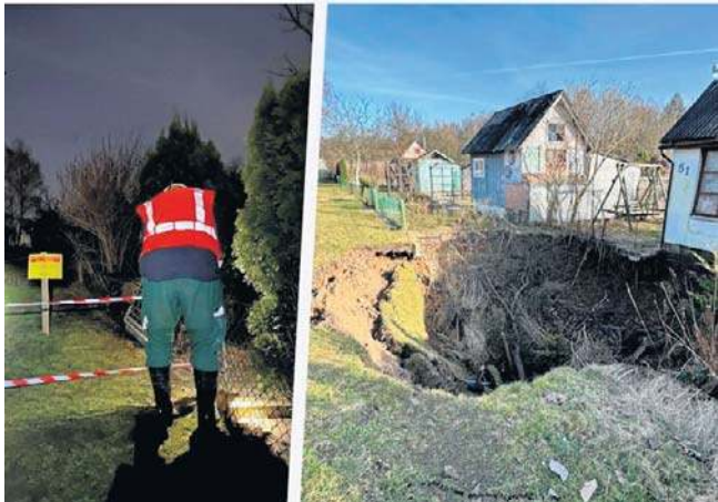
Nowe zapadlisko na terenie ROD „Gaj”. Ratownicy górniczy oznakowali niebezpieczny teren
