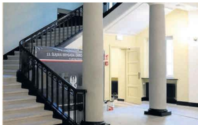
W gmachu przy Kilińskiego wyremontowano już m.in. hol
