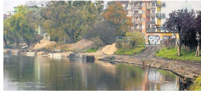
Prace na odcinku od Krakowskiej do hotelu Słoneczny Młyn ruszyły cztery miesiące temu
