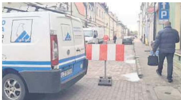
Ulica Staszica formalnie jest już placem budowy.
