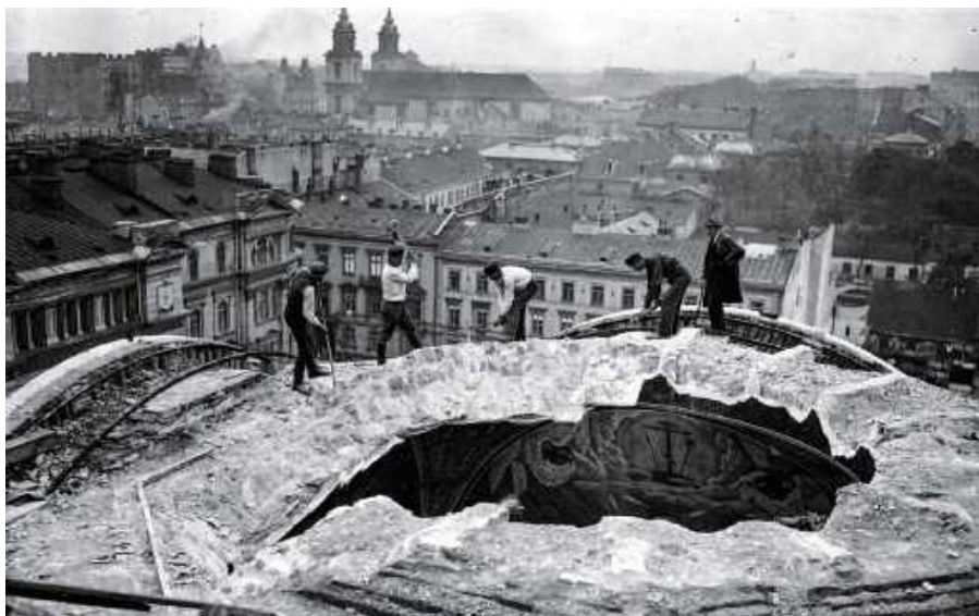
Rozbiórka soboru św. Aleksandra Newskiego.
