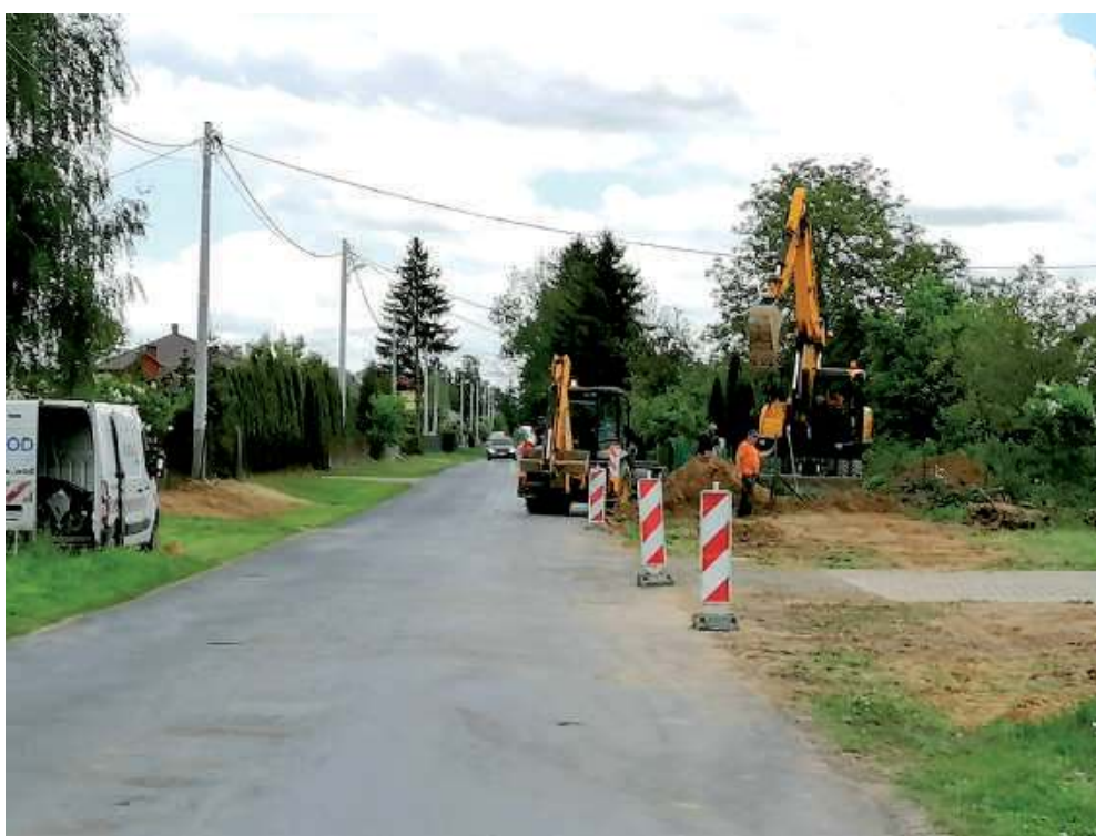
Budowa kanalizacji pochłonie 3,4 mln zł. Prace ruszyły w kwietniu i potrwać do grudnia
