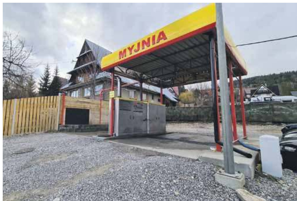
Myjnia w Kościelisku powstała bez wymaganego pozwolenia na budowę - twierdzi nadzór budowlany.
