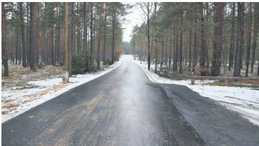
Droga Legbąd – Łosiny. Dotychczasową gruntową nawierzchnię zastąpił asfaltowy dywanik.
