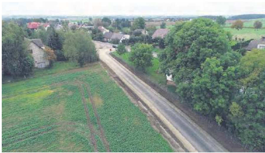
Przebudowana droga Bładowo – Białowieża.
