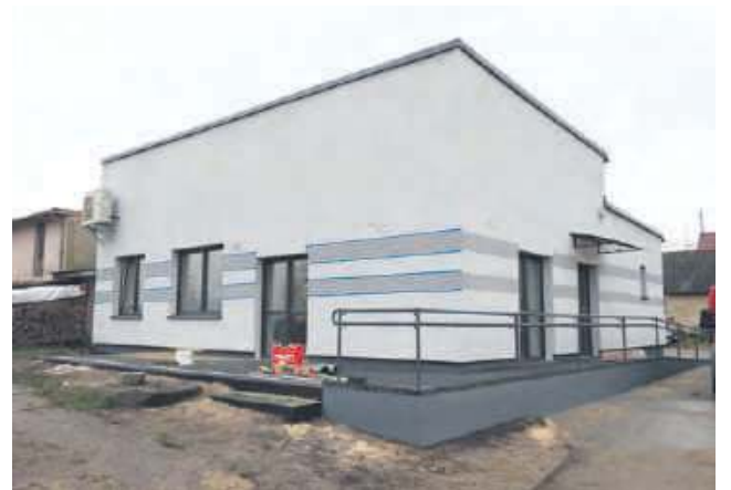
Dom Seniora w Wysokiej – widok z tyłu budynku.
