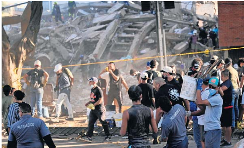
Wolontariusze i ratownicy szukają ocalałych w gruzach zawalonego budynku po trzęsieniu ziemi w Cali
