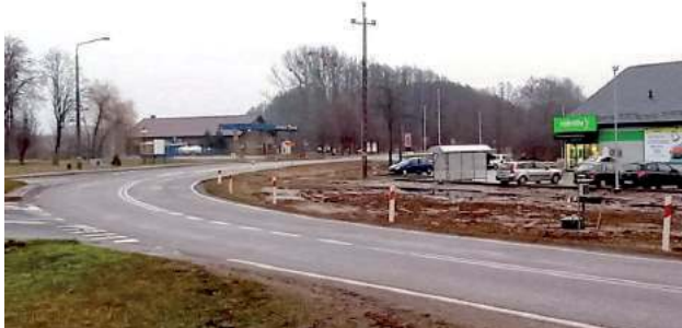
Jedynym czynnikiem nieco spowalniającym ruch jest pobliski zakręt w ciągu DW 819
