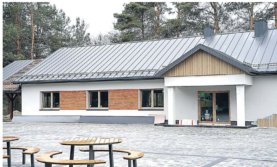
Prace w Borkach-Kosach trwają.
