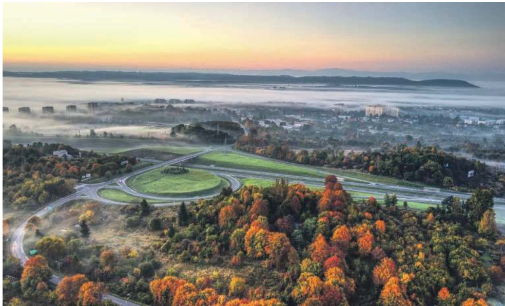
Węzeł baliński na autostradzie A4 w Chrzanowie
