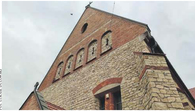
Odnowiony ceglany szczyt fasady kościoła św. Mikołaja w Chrzanowie
