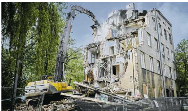
• Rozbiórka kamienicy przy ul. Franciszkańskiej
