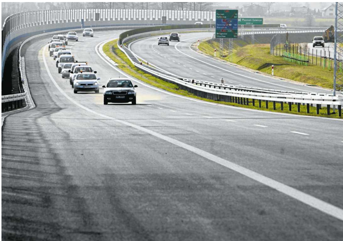
• Zachodnia obwodnica Poznania to droga S11. Jej budowa w Obornikach miała się rozpocząć w pierwszej połowie tego roku FOT. PIOTR SKÓRNIKI / AGENCJA WYBORCZA.PL
