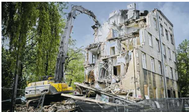
• Rozbiórka kamienicy przy ul. Franciszkańskiej
