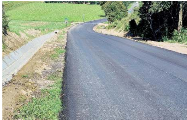
Kolejny etap przebudowy drogi powiatowej w kierunku Skierbieszowa
