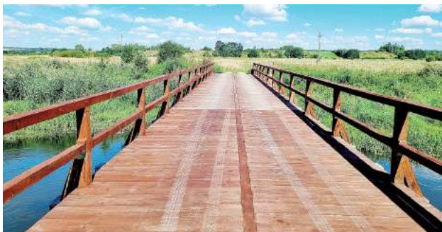
Wyremontowany most na rzece Wieprz, dzięki któremu można przejechać z Tarnogóry do Wału
