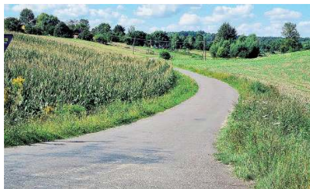
Droga dojazdowa do pól i lasów w Zalesiu
