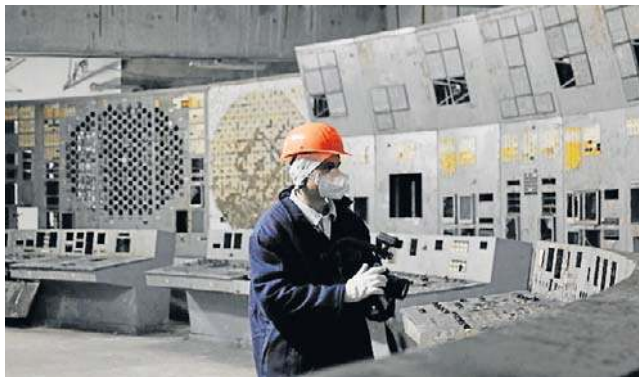
Pan Tomasz w sterowni bloku czwartego czarnobylskiej elektrowni. Dokładnie w nim doszło do katastrofy w 1986 r.
