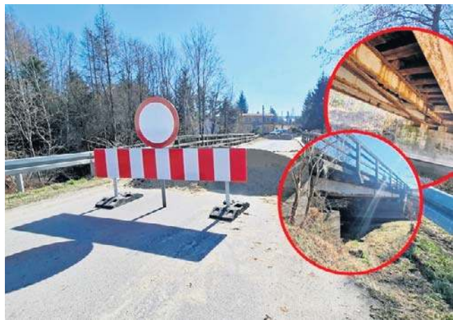
Prawie 3,5 mln za most na powiatówce Libusza-Wójtowa. Budowa ma ruszyć lada dzień
