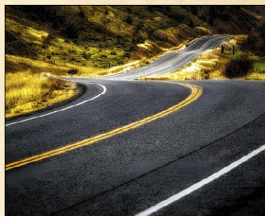
2. Droga w USA o nawierzchni z tarmacadamu
