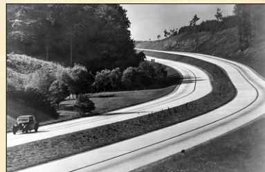
6. Stare zdjęcie niemieckiej autostrady
