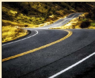
2. Droga w USA o nawierzchni z tarmacadamu
