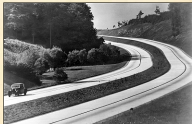
6. Stare zdjęcie niemieckiej autostrady
