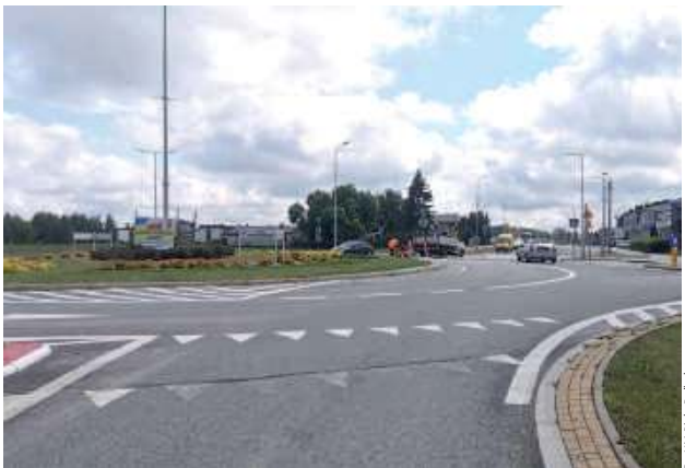
Niedawno zakończono prace przy ulicy Janowskiej. Część ulicy zyskała dodatkowe pasy ruchu, na rondzie Żołnierzy Wyklętych namalowano pasy dla kierowców
