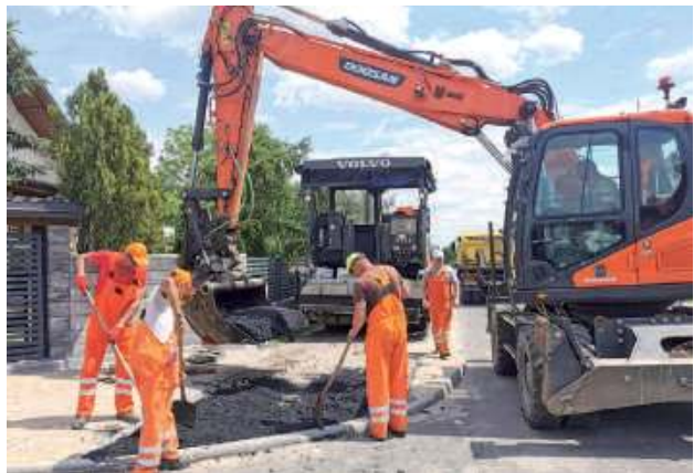
Przy ulicy Podmiejskiej trwają intensywne prace. Mają być zakończone do 30 czerwca
