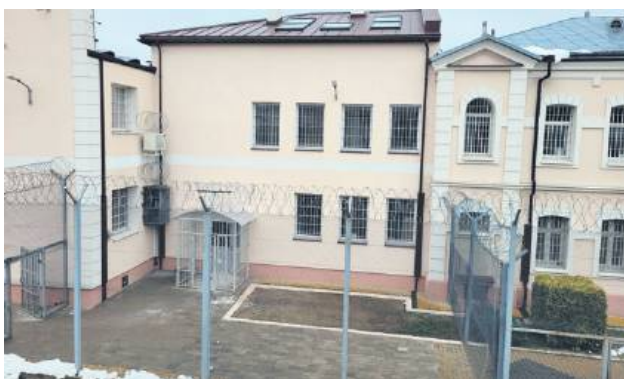
Dzięki wdrożeniu programu modernizacji Służby Więziennej, ZK w Zamościu wzbogacił się o nowy budynek o łącznej powierzchni 322 mkw. Fot. Paweł Bednarczuk
