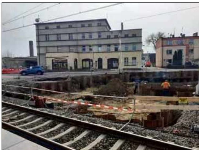
Budowa tunelu pod torami potrwa do października.
