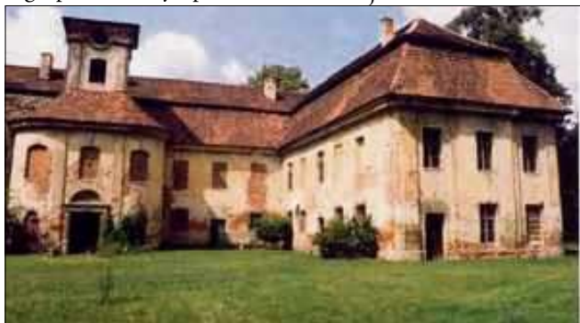
Być może już niedługo budynek zostanie wyremontowany.
