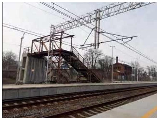
...potem rozbierano jej fundamenty oraz schody.
