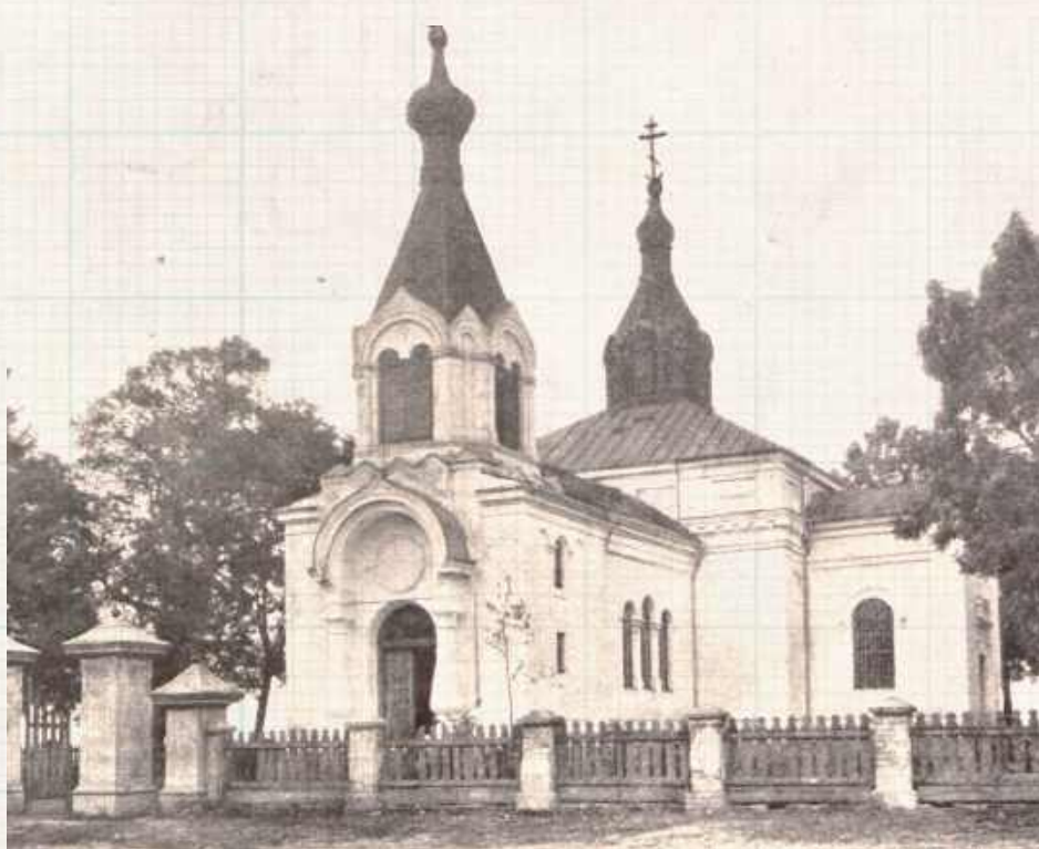
W czasie opisywanych wydarzeń Jabłoń miał stosunkowo nową, wybudowaną przez Piotra Strzyżewskiego cerkiew. Oczywiście w 1874 została odebrana unitom i przekazana prawosławnym. To przy niej miały miejsce pierwsze objawienia
