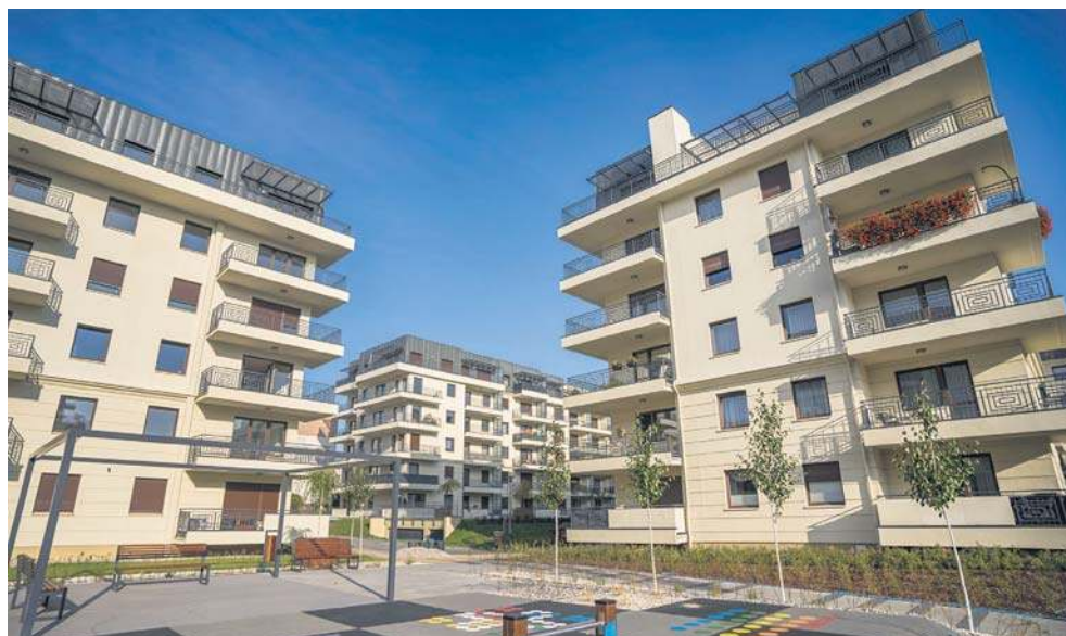
Jedną z budzących zachwyt inwestycji, w których P.W. „Lech” było generalnym wykonawcą, jest Osiedle Paryskie.
