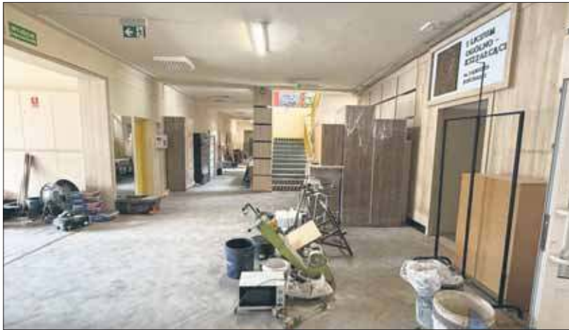
Remont I Liceum Ogólnokształcącego w Jaworznie
