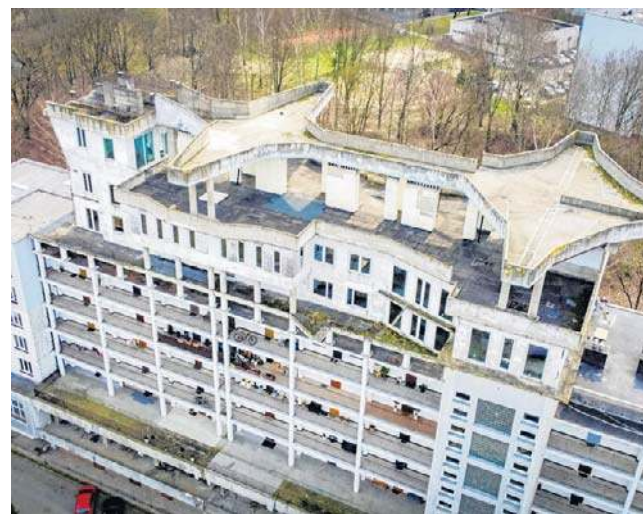
Część nadbudowy została już rozebrana
