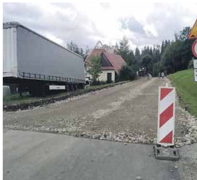
Remont potrwa do końca października tego roku.
