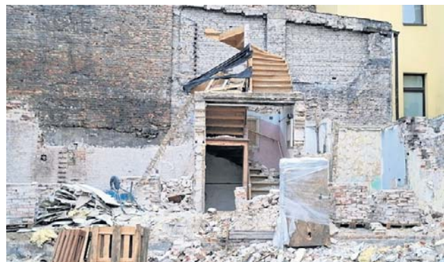
Tak prezentowały się żeliwne schody pod koniec rozbiórki kamienicy przy Sukienniczej 3
