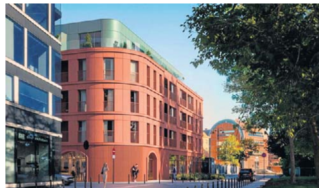
W sąsiedztwie Hali Targowej przy ulicach Magdzińskiego i Podwale ma powstać taki budynek wielorodzinny
